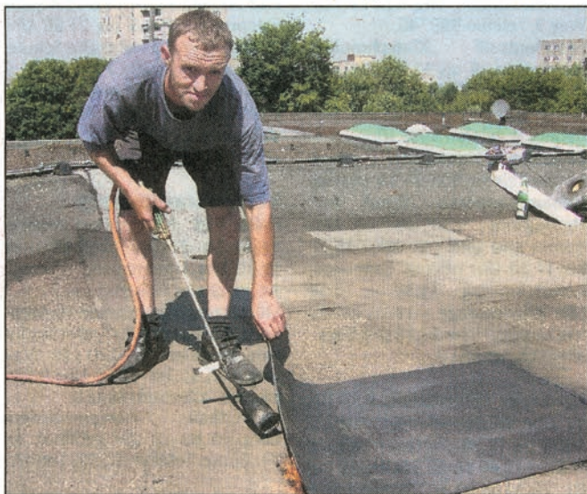
35 Grad: Dachdecker Eduard Dombrowski beim Verschweißen von Teerpappe mit dem Gasbrenner.
